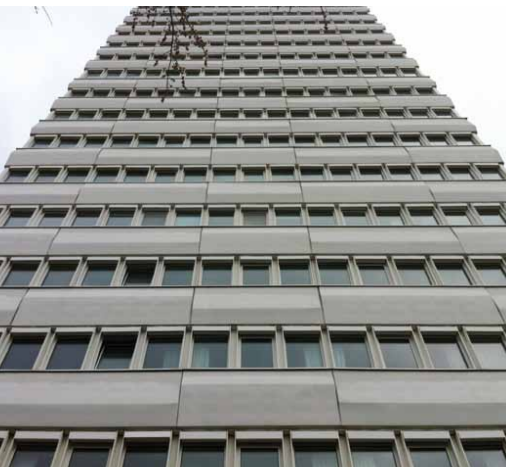
Hochhausfassade, Fenster in den 1990er Jahren erneuert – Systemtechnik
